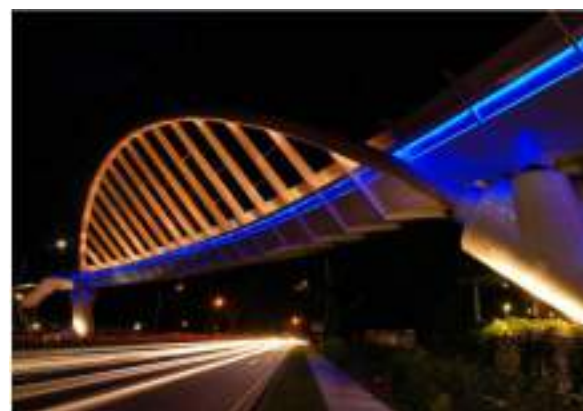
橋の形状を浮かび上がらせている事例
