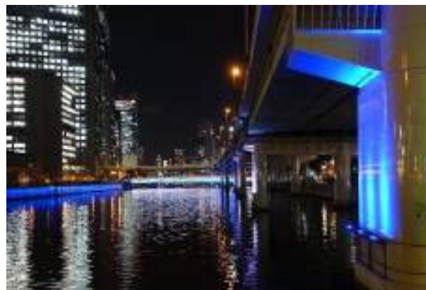
橋梁をライトアップしている事例
