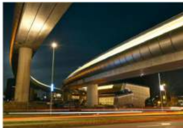
高速道路の側面に照明器具を設置している事例
