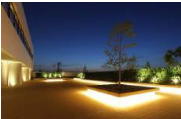
ベンチ間接照明の事例
