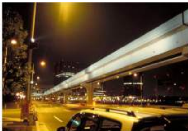
対岸から高速道路の側面をライトアップしている事例
