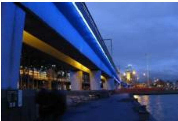
高速道路の側面に照明器具を設置している事例
