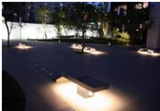
ベンチ間接照明の事例
